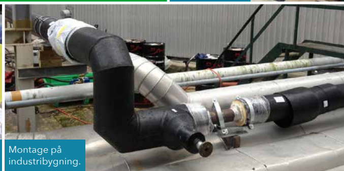
Rustfrie T-stykke med flange.
